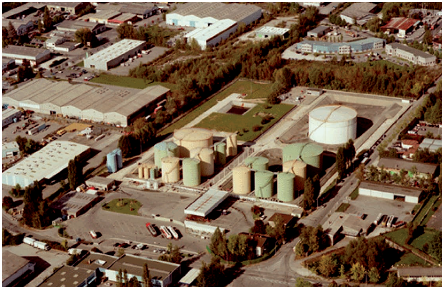
Dépôt pétrolier « GPHS Annecy - Vovray ».
