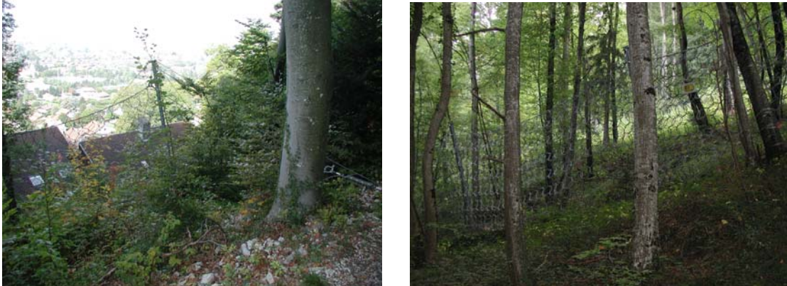
Figure 9- Eboulements et chutes de blocs - filets protecteurs- au lieu-dit « le Petit Port » au dessus du lotissement « les Barattes » à Annecy-le-Vieux
