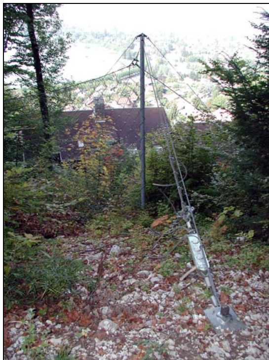
Figure 14 - Filets dynamiques positionnés en amont du lieu-dit « Les Barattes »
