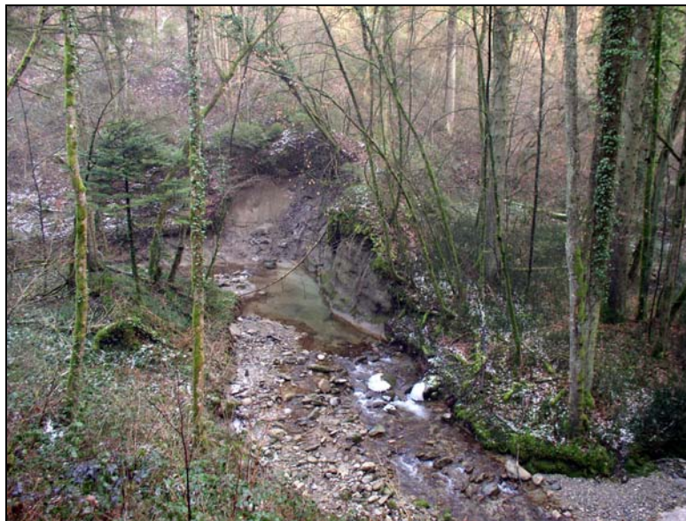
Figure 15- Erosion de berges du ruisseau le Genon
