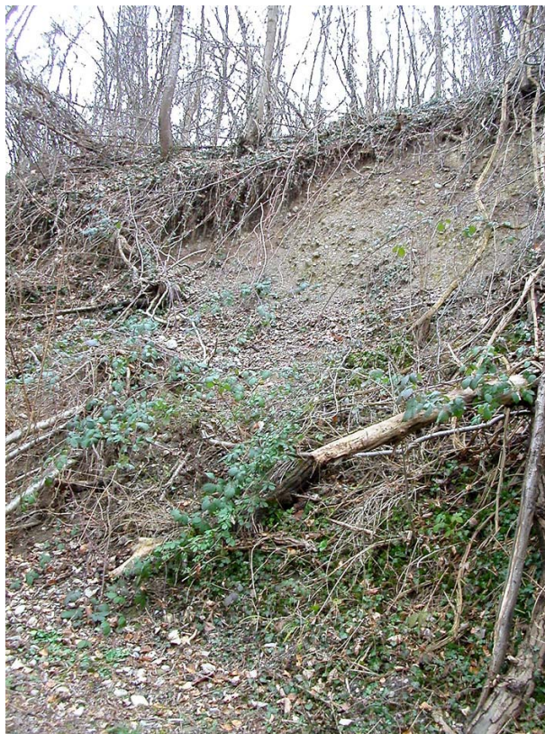
Vetraz-EG1 : Rive droite de l'Arve, au niveau du lac de Creuze – Glissements de talus généralisés.
