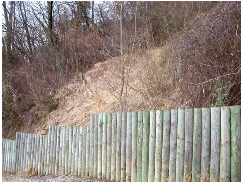
Vetraz-EH1 : Rive droite de l'Arve, au niveau du lac de Creuze – Développement d'une humide sur le talus, affectée de glissements.
