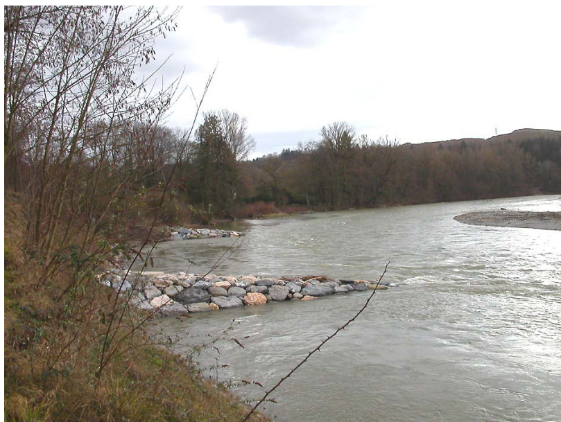
Vetraz-OT1 : Rive droite de l'Arve, au niveau de l'ancien lac de Creuze – Épis en enrochements afin de protéger les berges.
