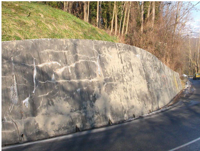
Vetraz-OG3 : RD185, sous le stade de Vétraz – Mur de confortement de talus en béton, drainé.
