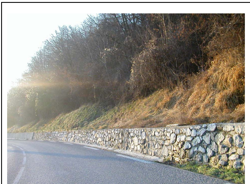
Vétraz-OG1 : RD1205, au dessus des Grandes Iles – Succession de murs empierrés confortant le talus amont de la route.
