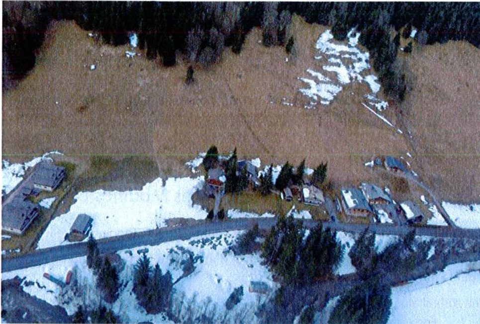
Photo 6 : seule le fond de vallée avec la route et le torrent participe activement à la dissipation de l'énergie
