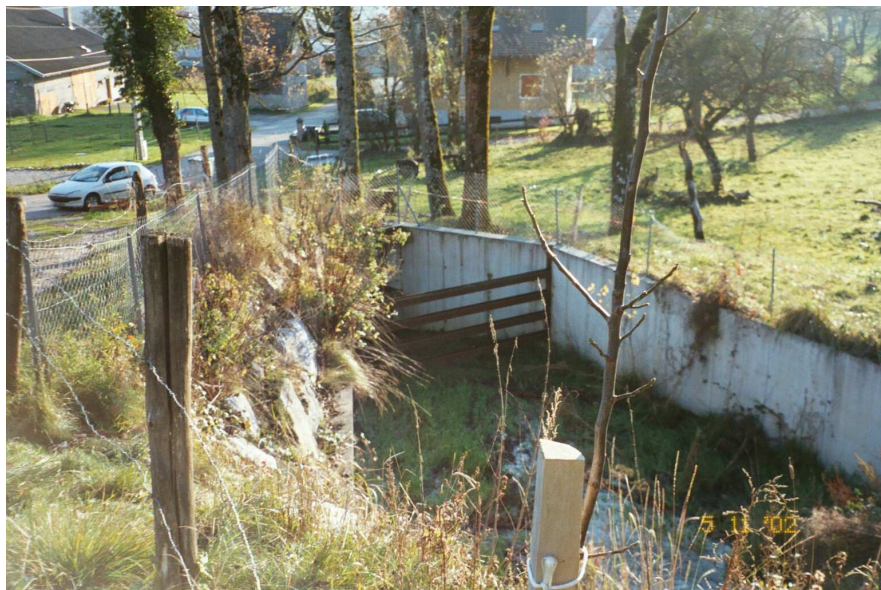
Photographie 1 – Ouvrage de correction torrentielle en amont de CHEZ-LES-GIRARD Ouest.
