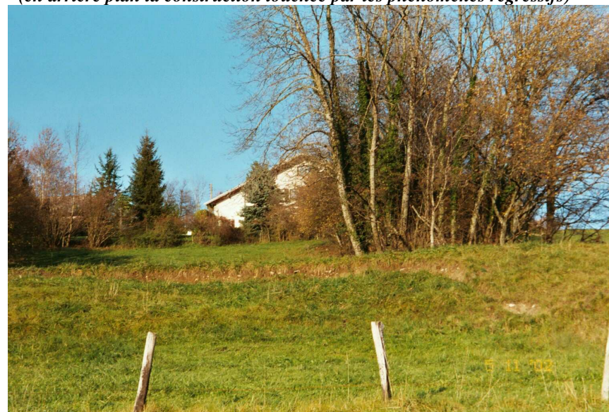
Photographie 4 – Glissement de CHEZ-LES-GIRARD (en rive droite du ruisseau) (en arrière plan la construction touchée par les phénomènes régressifs)
