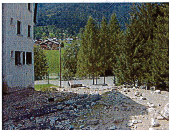
Présence de boue sur les murs de l'immeuble entre le Bon Nant et la route départementale.
