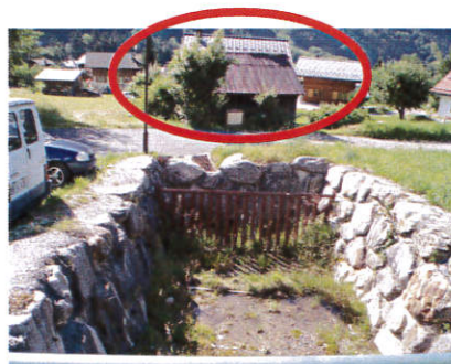
Illustration 6: Bac de décantation
