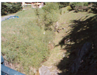
Illustration 4: lit du ruisseau Amont du bac de décantation
