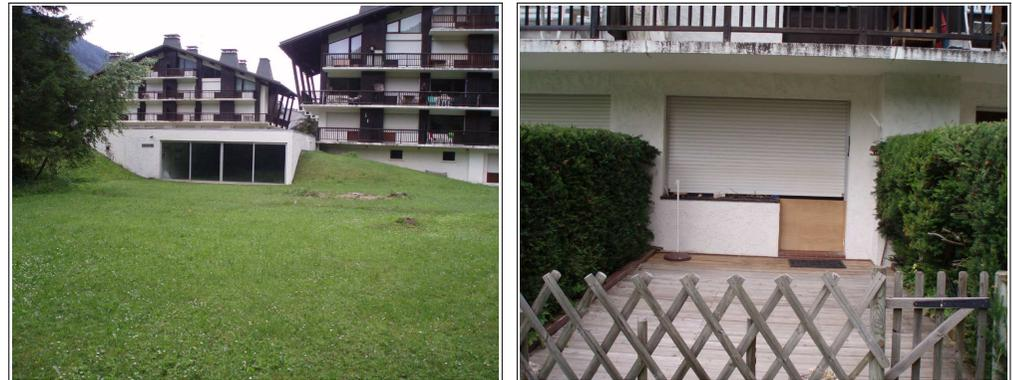
De plus, à ce niveau, les berges du Bon Nant semblent submersible en cas de forte crue. En rive gauche, des immeubles avec des ouvertures très vulnérable (baie vitrée) en cas de crue, sont construits à quelques mètres du torrent. Ainsi plusieurs appartements de vacances et une piscine couverte peuvent être inondés.
