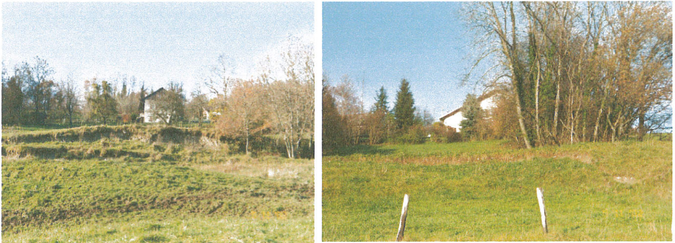
Glissement de terrain « Chez-Les-Girard » (rive droite du ruisseau) - Extrait de la note de présentation
