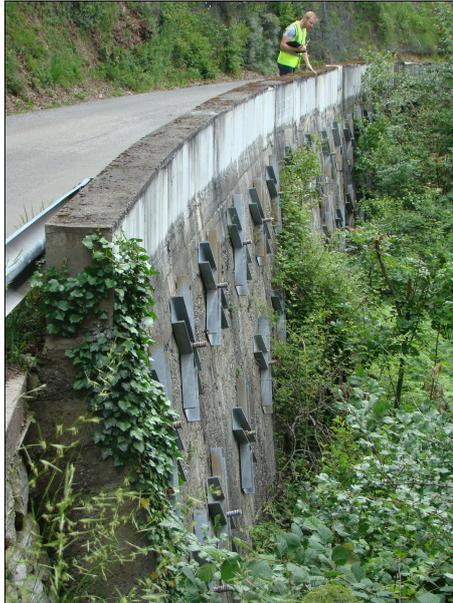
**Fig. 18 :** Mur ancré sous la route de Rontalon [Source : IMS<sub>RN</sub>]
