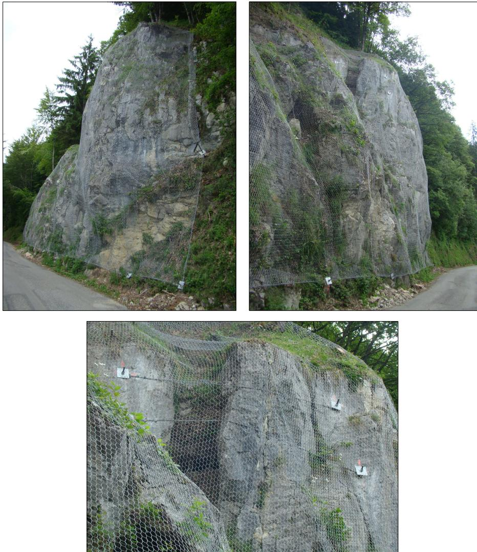
**Fig. 17** : Escarpement rocheux conforté sur la commune de THYEZ [Source : IMS<sub>RN</sub>]
