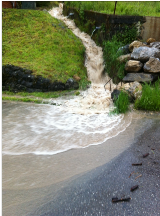
Fig. 10 : Ruissellement sur la chaussée suite à l'épisode orageux du 04 mai 2015 [Source : Mairie de VILLE-EN-SALLAZ ]
