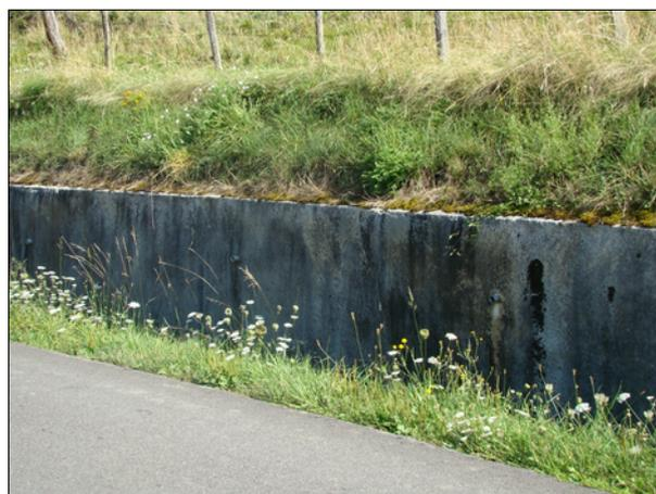
**Fig. 13 :** Mur de soutènement en béton avec drains le long de la RD 123, Vers le bas [Source : IMS<sub>RN</sub>]
