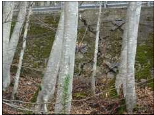
Fig. 19 : Mur de confortement avec croix de Saint-André présentant une importante fissuration, sous la RD 6 en amont de Lachat (sur la commune de CHÂTILLON-SUR-CLUSES, en limite avec SAINT-SIGISMOND) [Source : IMS RN ]
