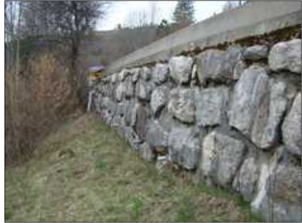
Fig. 18 : Gabions le long de la route de la Motte (à gauche) et enrochement bétonné avec drains sous la RD 6, en contrebas de l'église (à droite) [Source : IMS RN ]
