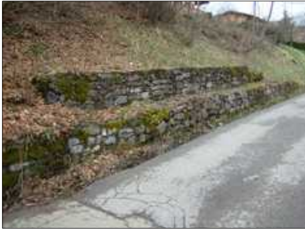
Fig. 18 : Gabions le long de la route de la Motte (à gauche) et enrochement bétonné avec drains sous la RD 6, en contrebas de l'église (à droite) [Source : IMS RN ]
