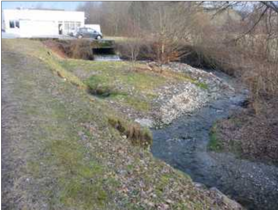
Fig. 14 : Bassin de rétention sur le Nant d'Iné, le long de la RD 9 [Source : IMS RN ]
