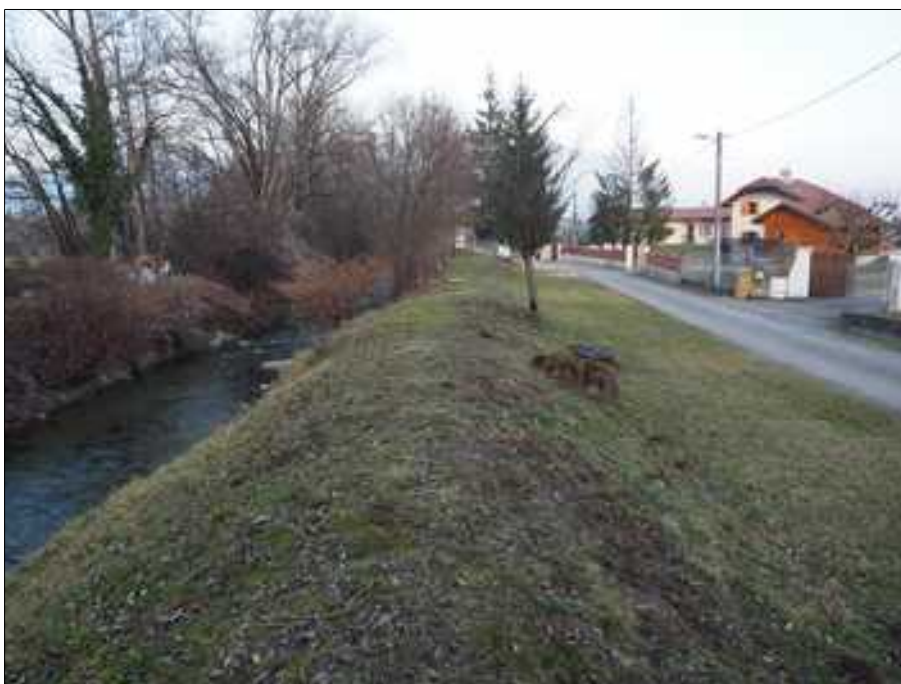
Fig. 12 : Levée de terre (digue) en rive droite du Foron [Source : IMS RN ]
