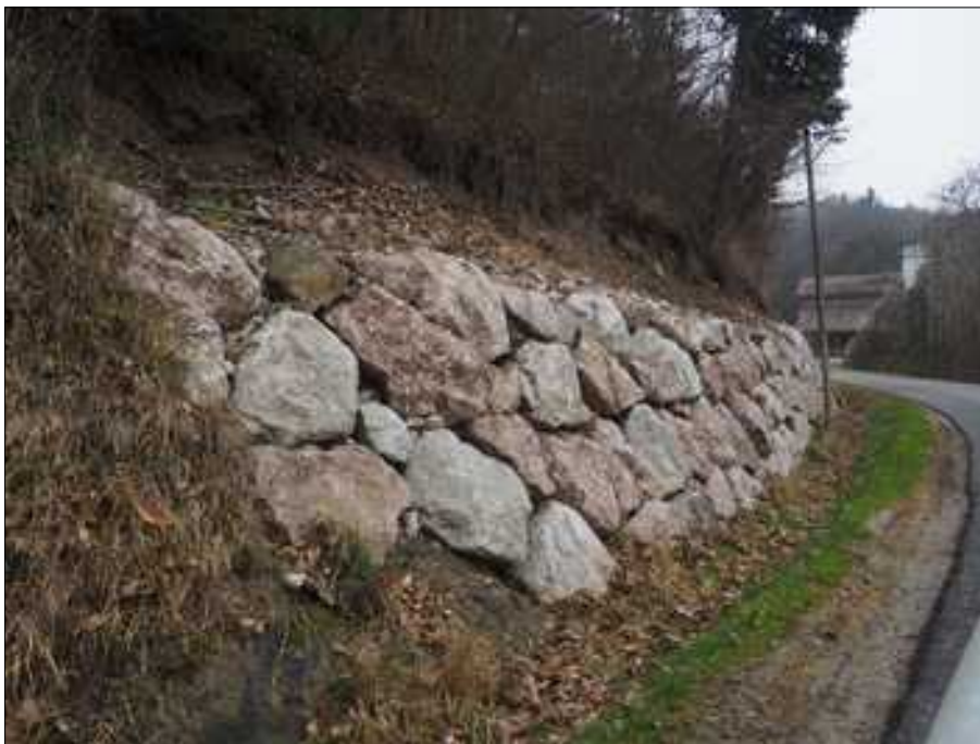
Fig. 13 : Enrochement le long de la RD 225, à l'Est du Chalet [Source : IMS RN ]
