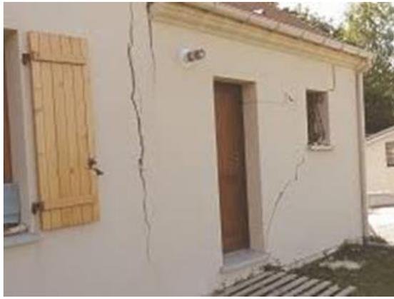
Fig.9 illustration des effets prévisibles d'une augmentation des descentes de charges en zone d'aléa « mouvement de terrain »
