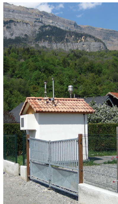
Station de mesure de Passy
