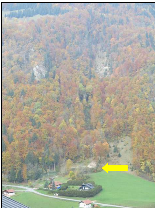
Figure 13: Vue d'ensemble des sites 4 et 5. Le merlon est visible sur le cône de déjection (flèche jaune).
