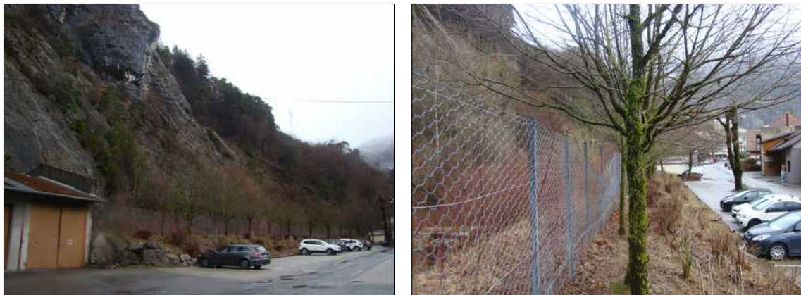
Fig. 30 : Merlon en terre (surmontée d'un grillage) en bas de versant de la Roche de THÔNES, protégeant des habitations [Source : IMS RA ]
