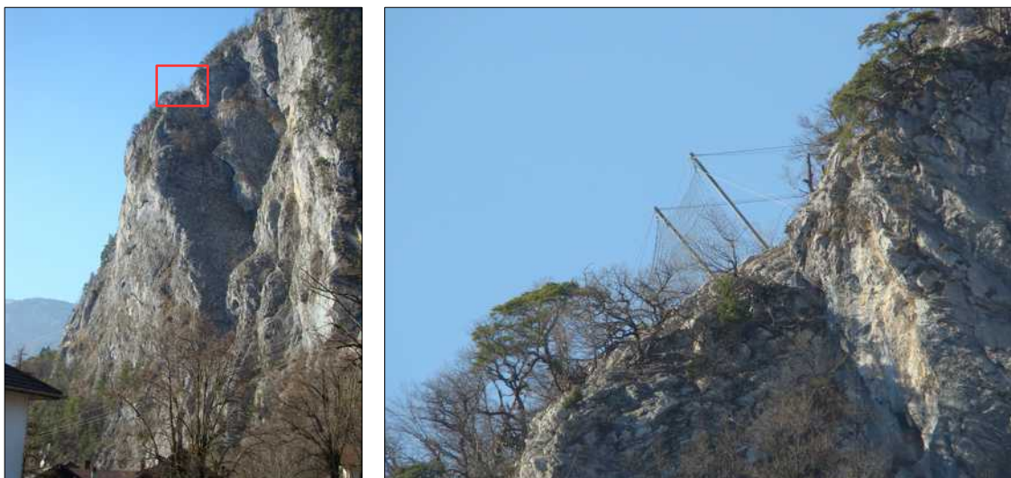
Fig. 28 : Filets ASM en haut de versant de la Roche de THÔNES [Source : IMS RN ]
