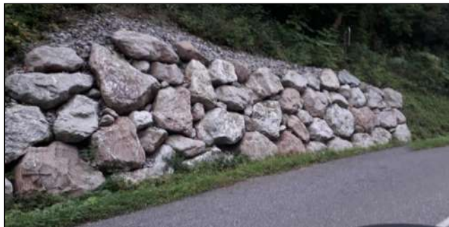
Ouvrage de soutènement drainant - RD36 (RTM)
