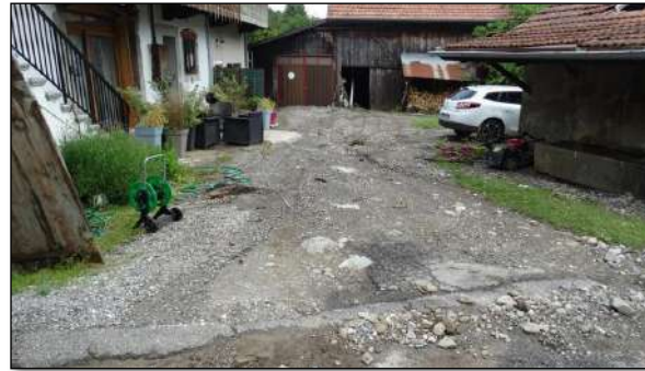
Ruissellement dans les habitations de Fillient – crue 2018 (RTM)
