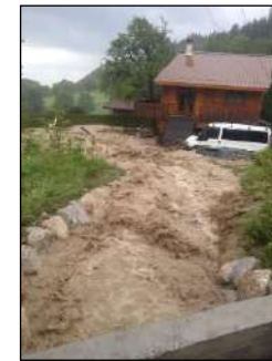
Lit enroché peu profond favorable au débordement en cas de remontée du lit par dépôt des matériaux charriés ; crue de 2018 – La Basse (RTM et riverains)
