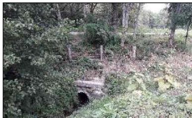
Ouvrage de franchissement de la route au hameau des Mouilles et dépôts de la crue de 2018 dans la dépression en amont (RTM)
