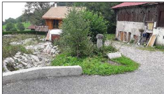
Lit enroché peu profond favorable au débordement en cas de remontée du lit par dépôt des matériaux charriés ; crue de 2018 – La Basse (RTM et riverains)
