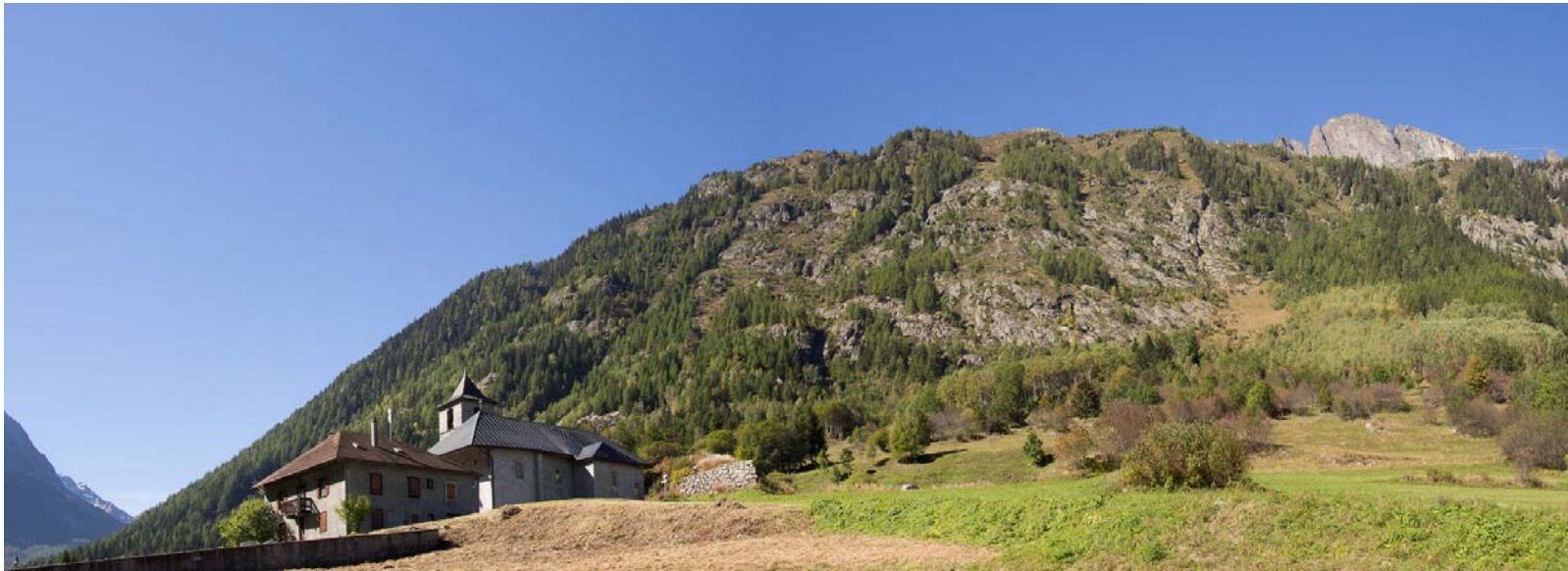
L'église et la cure, protégées par leur tourne (dont une première mention date du XVe siècle, l'ouvrage actuel datant de 1861 réhaussé en 1955), dans les couloirs des avalanches du Creux de la Ravine (à droite) et de la Golèse (au centre)
