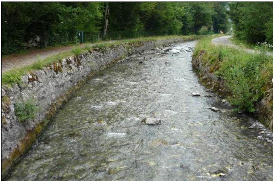
Fig. 20 : Protections de berge le long du Clévieux, en amont de la passerelle [Source : IMS RN ]
