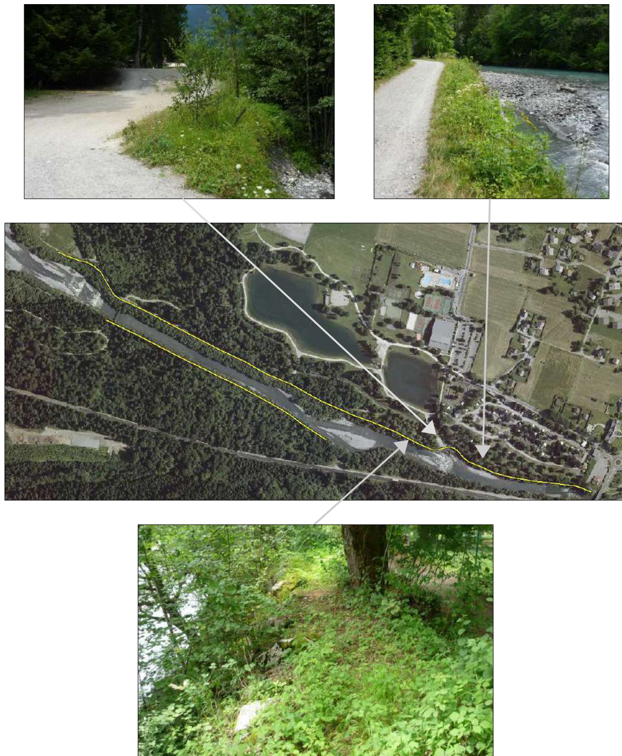
Fig. 18 : Localisation et photographies des ouvrages de protection hydraulique sur le Giffre [Source : IMS RN ]
