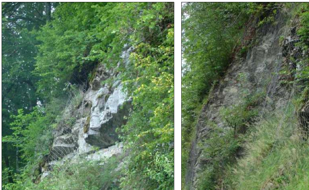
Fig. 24 : Filets et grillages plaqués sur les escarpement en bordure de la RD 4, au Nord de « Chez Renand » (à gauche) et en bordure de la RD 254, au Sud-Ouest de « Le Jourdi » (à droite) [Source : IMS RN ]
