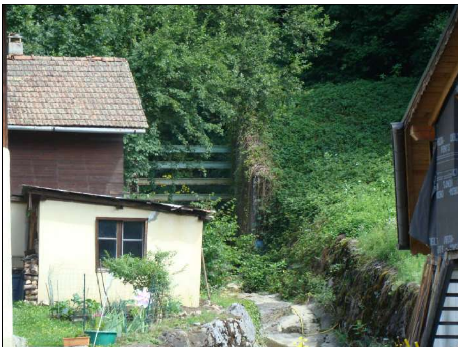
Fig. 21 : Peigne à embâcles au débouché du Bérrouze [Source : IMS RN ]
