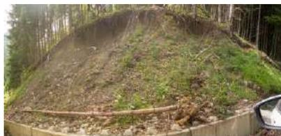
Le phénomène classique montre généralement une surface de rupture bien marquée, formant des crevasses caractéristiques en surface.
