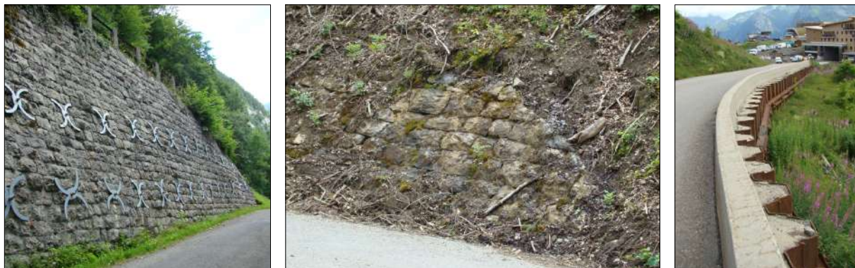
Fig. 26 : Exemples d'ouvrages de soutènement présents sur la commune de SAMOËNS (enrochements, avec ou sans renforts, et mur en palplanches) [Source : IMS RN ]
