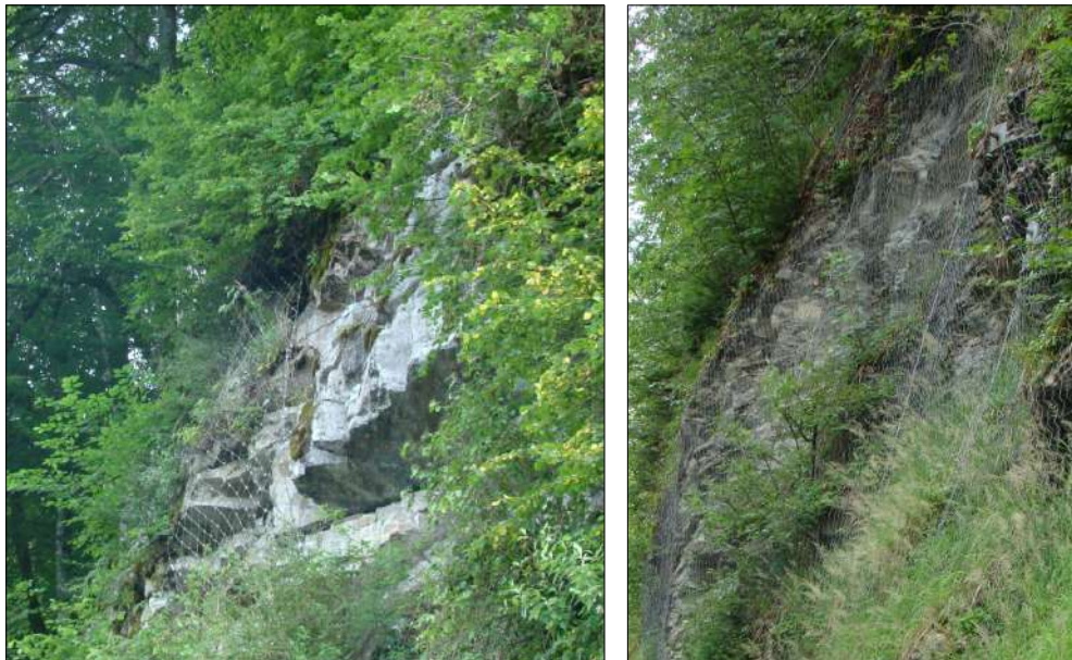
Fig. 24 : Filets et grillages plaqués sur les escarpements en bordure de la RD 4, au Nord de « Chez Renand » (à gauche) et en bordure de la RD 254, au Sud-Ouest de « Le Jourdi » (à droite) [Source : IMS RN ]
