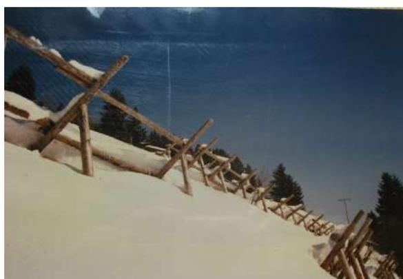
Figure 100: Paravalanche en bois construit dans la zone de départ de l'avalanche (1986) – source RTM
