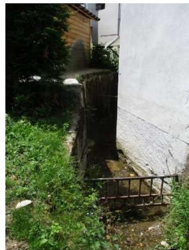
Figure 22: Grilles à l'entrée de la section couverte
