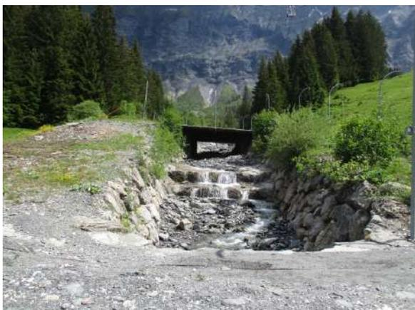
Figure 54: Platelage pour le passage de la piste de ski et enrochement de chaque côté du chenal
