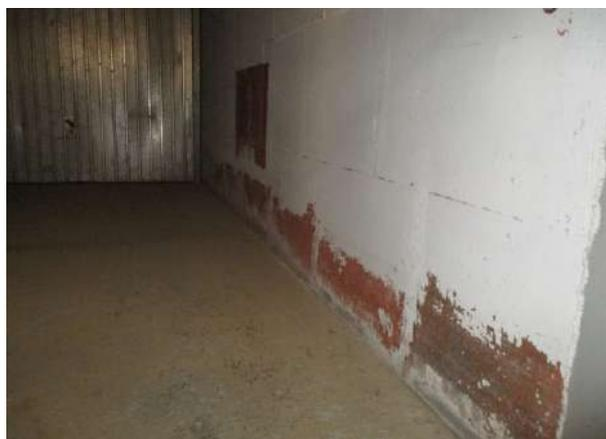
Figure 15: Laisse de crue dans les garages – 1 m d'eau environ
