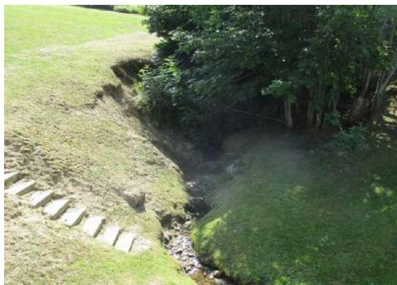
Figure 58: Érosion de berges à l'amont immédiat de la section busée
