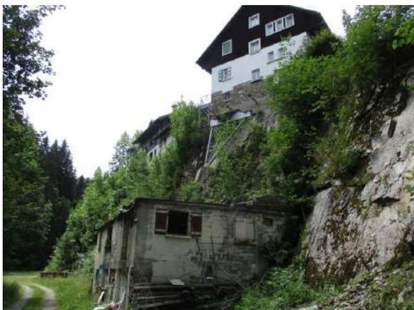
Figure 69: Bâtiment ayant été conforté par un buton ancré
