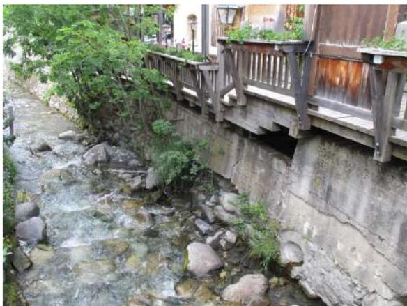
Figure 30: Érosion du mur et de la berge en rive droite au niveau d'une terrasse.
