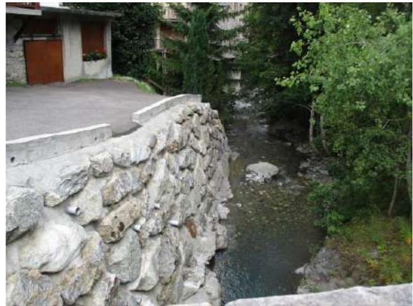
Figure 75: Remblais et enrochement à l'aval du pont de l'impasse de la Forge
