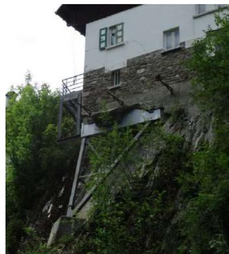
Figure 70: Ouvrage de confortement suite à l'écroulement d'une masse rocheuse
