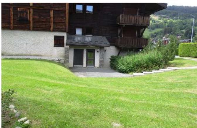
Figure 16: Immeuble inondé – côté nord-est, porte par où l'eau est entrée
