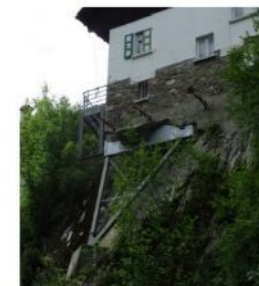
Figure 66: Ouvrage de confortement suite à l'écroulement d'une masse rocheuse
