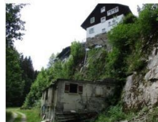
Figure 67: Bâtiment ayant été conforté par un buton ancré
