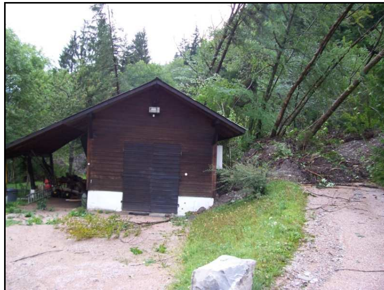
Photographie 13: Glissement de terrain au lieu dit « LA SOLITUDE » suite aux intempéries du 22 août 2005.
