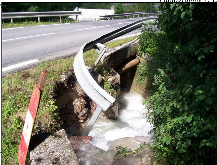
Photographie 8: Torrent de Melon le 23 août 2005. Noter l'affouillement à l'entrée de la buse sous la RD22.
