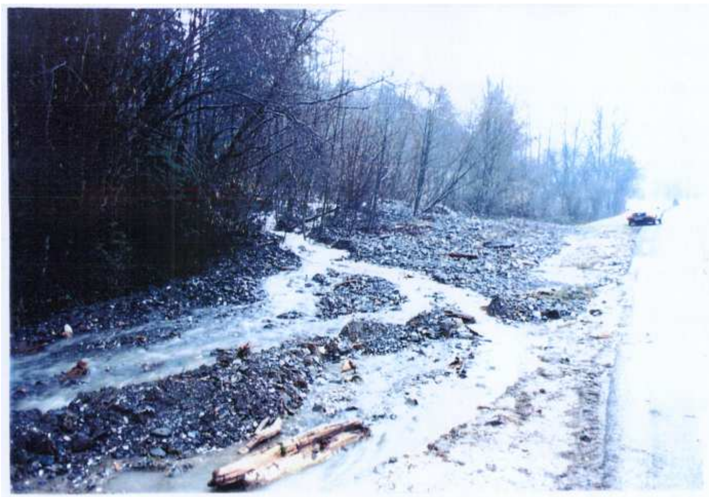
Photo n° 6 : Engrèvement par le ruisseau de Château Vert juste en amont du croisement avec le CD 16. Le CD 909 a été coupé à partir de 3 heures du matin jusqu'à 9 heures le 14.02.1990
