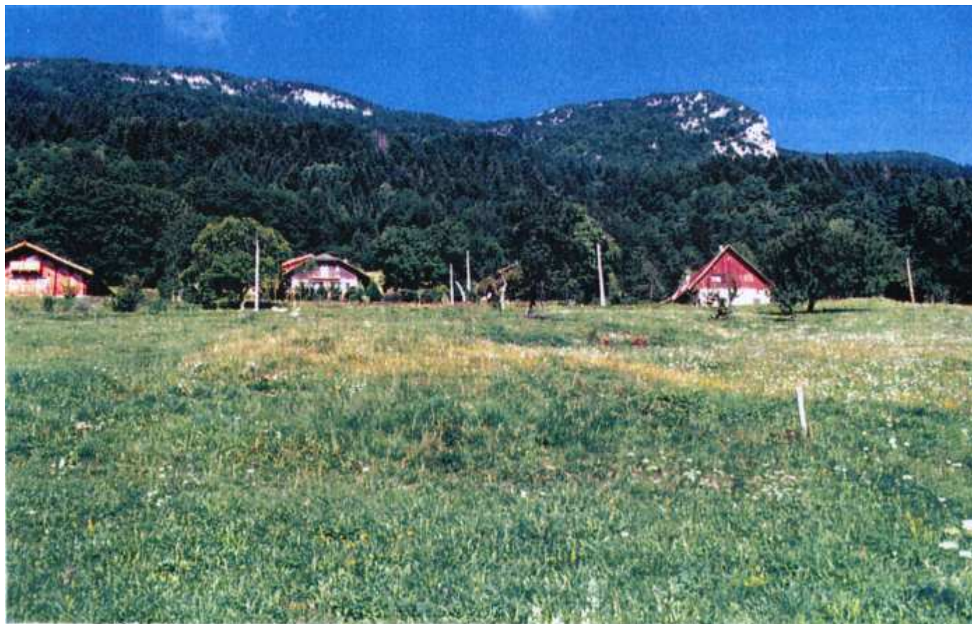
Photo n°5 : Glissement de terrain de la Côte
