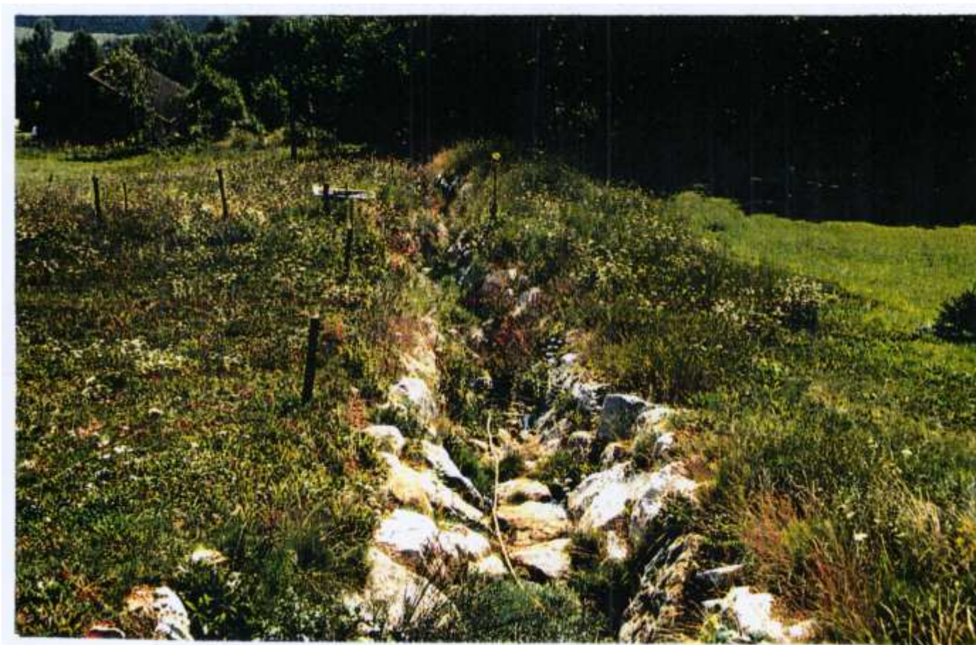
Photo n°7 : Ouvrage de protection. Aménagement du torrent de Gravez. Enrochement du lit.
