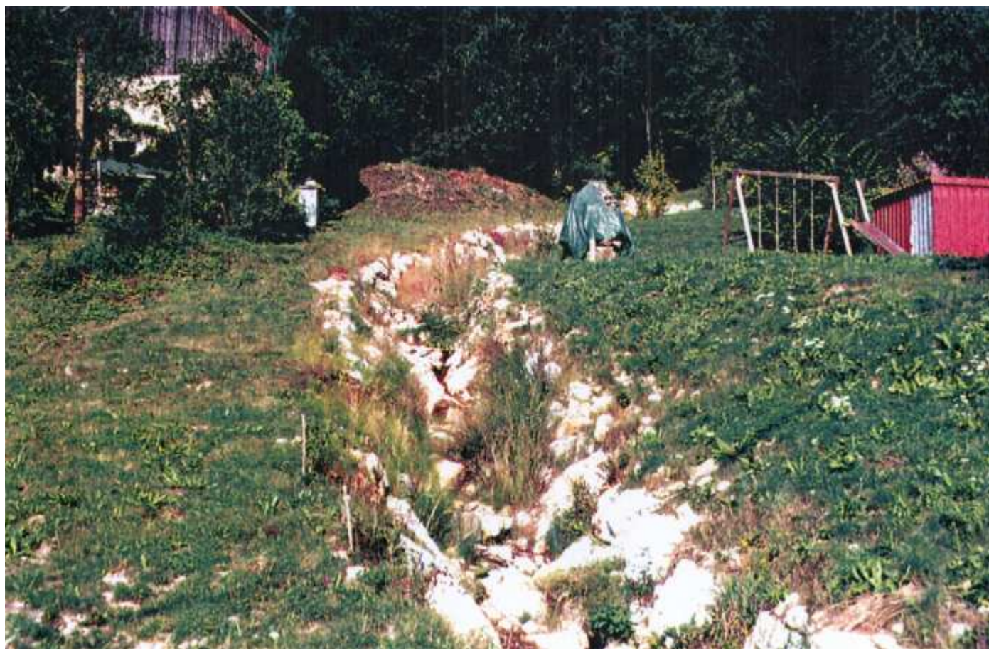
Photo n°4 : ruisseau de Gravet après travaux
