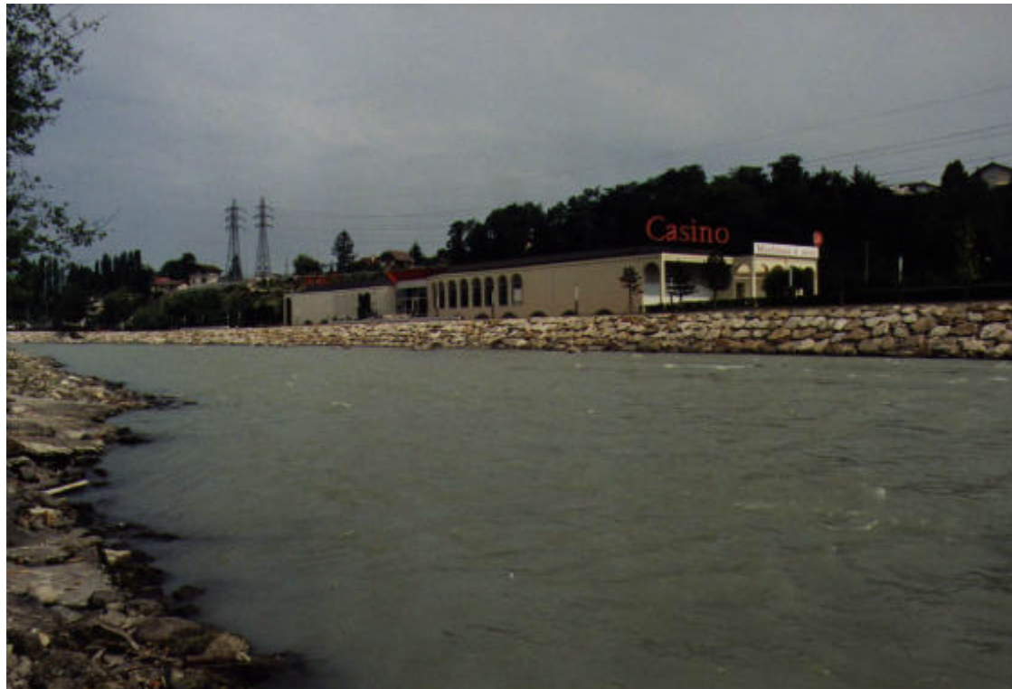
Photo 5 : Protections de berges en enrochements (Cliché RTM – 18/08/2000)
