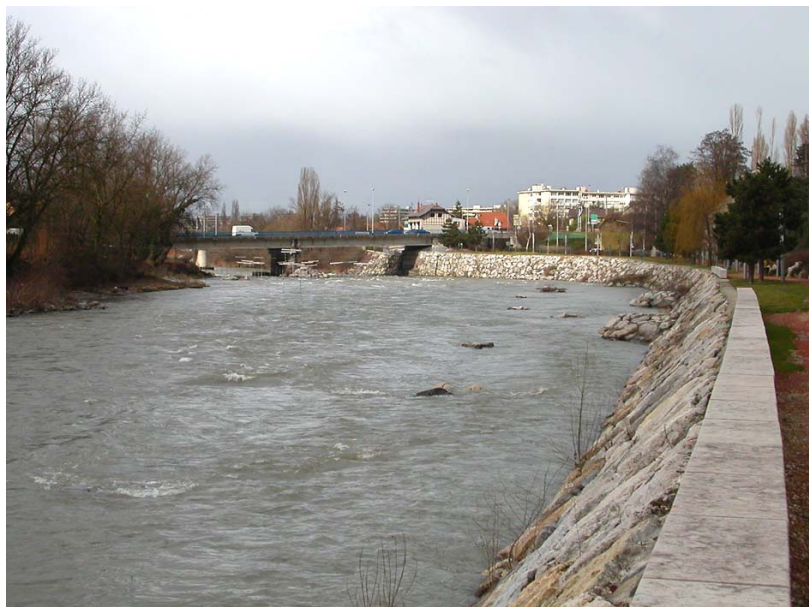
Annemasse-OGT2 : L'Arve, en rive droite, au niveau du Casino – Endiguement de la rivière par des berges en enrochements et épis.
