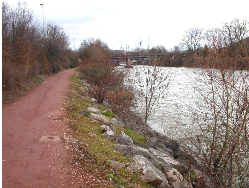
Annemasse-OGT1 : L'Arve, en rive droite en amont du pont de la RD1206 – Confortement de berges par enrochements.
