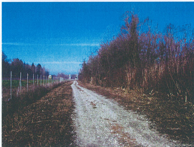
Arenthon-OT4 : Entre l'A40 et l'Arve, face aux Iles de Clermont – Digue de protection de la rivière aux abords de l'autoroute
