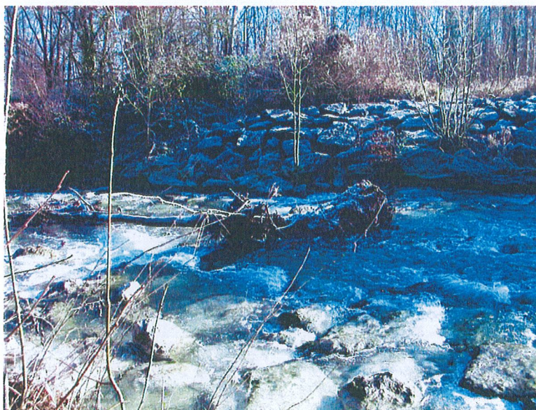
Arenthon-OT1 : Torrent du Foron – Enrochements en rive droite en amont de la confluence avec l'Arve.
