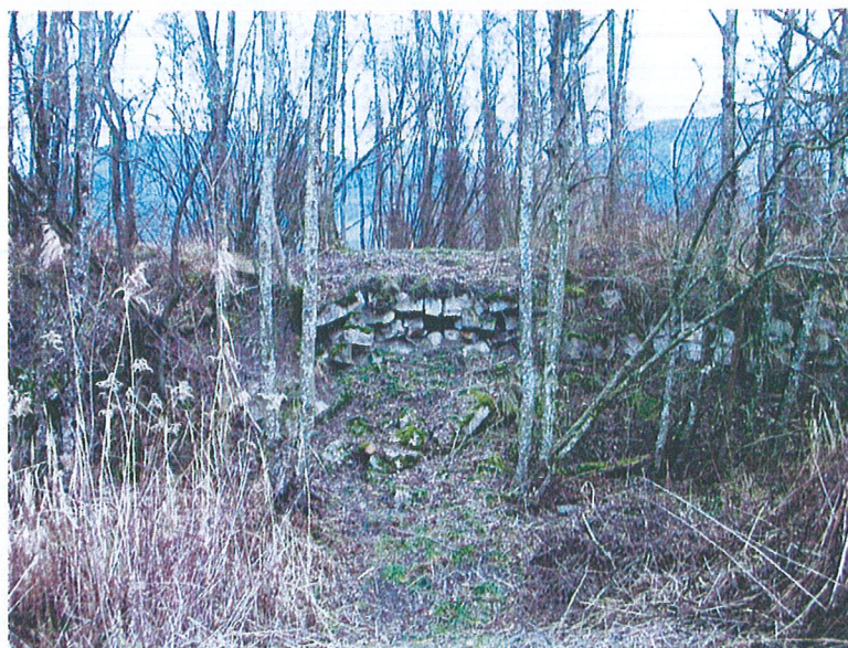
Arenthon-OT3 : Rivière de l'Arve au niveau de l'ancienne passerelle (Iles de la Barque) – Reste d'anciennes digues.
