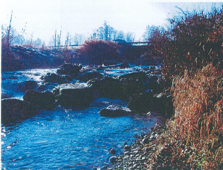
Arenthon-OT2 : Torrent du Foron – Seuil en amont de la confluence avec l'Arve.
