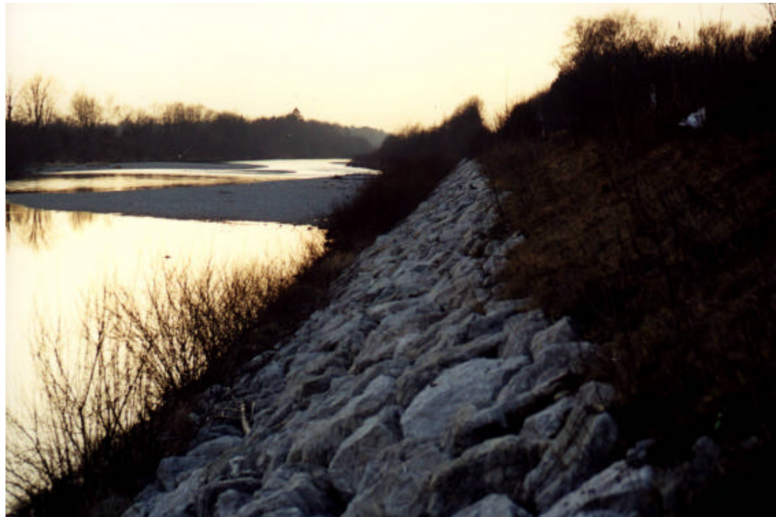
Photo 5 : Enrochements des berges de l'Arve à Ayze (Cliché RTM – 12 / 01 / 2000)
