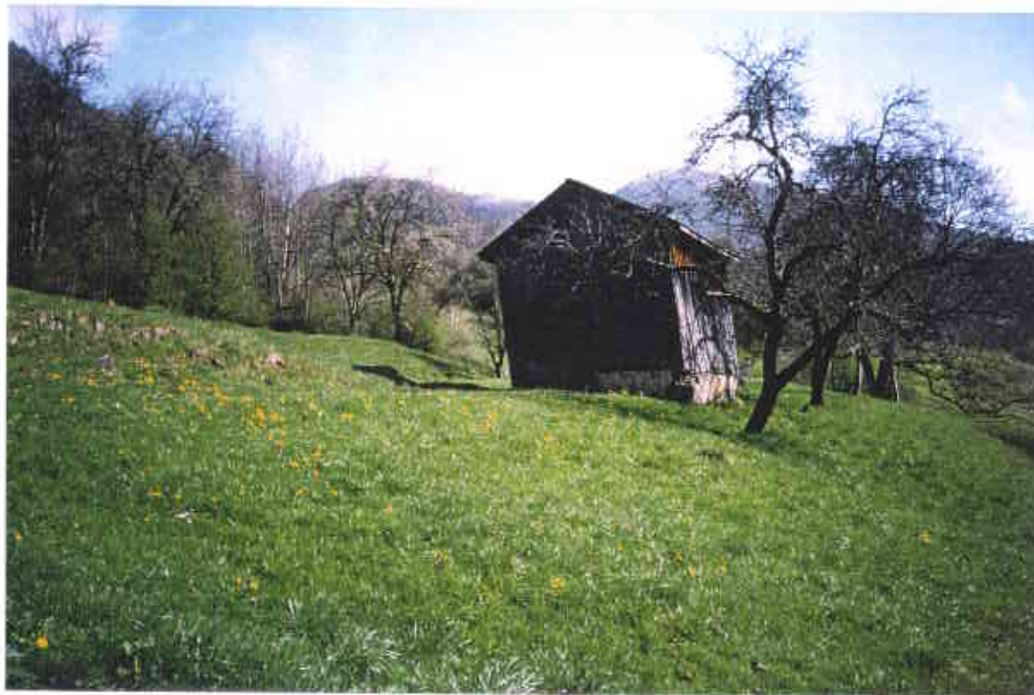
Photo 7 : Mouvement de terrain destabilisant une grange.
