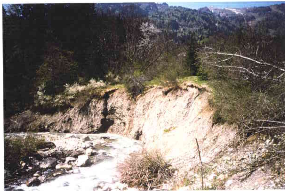
Photo 10 : Extrado d'un méandre affouillé par le Risse.
