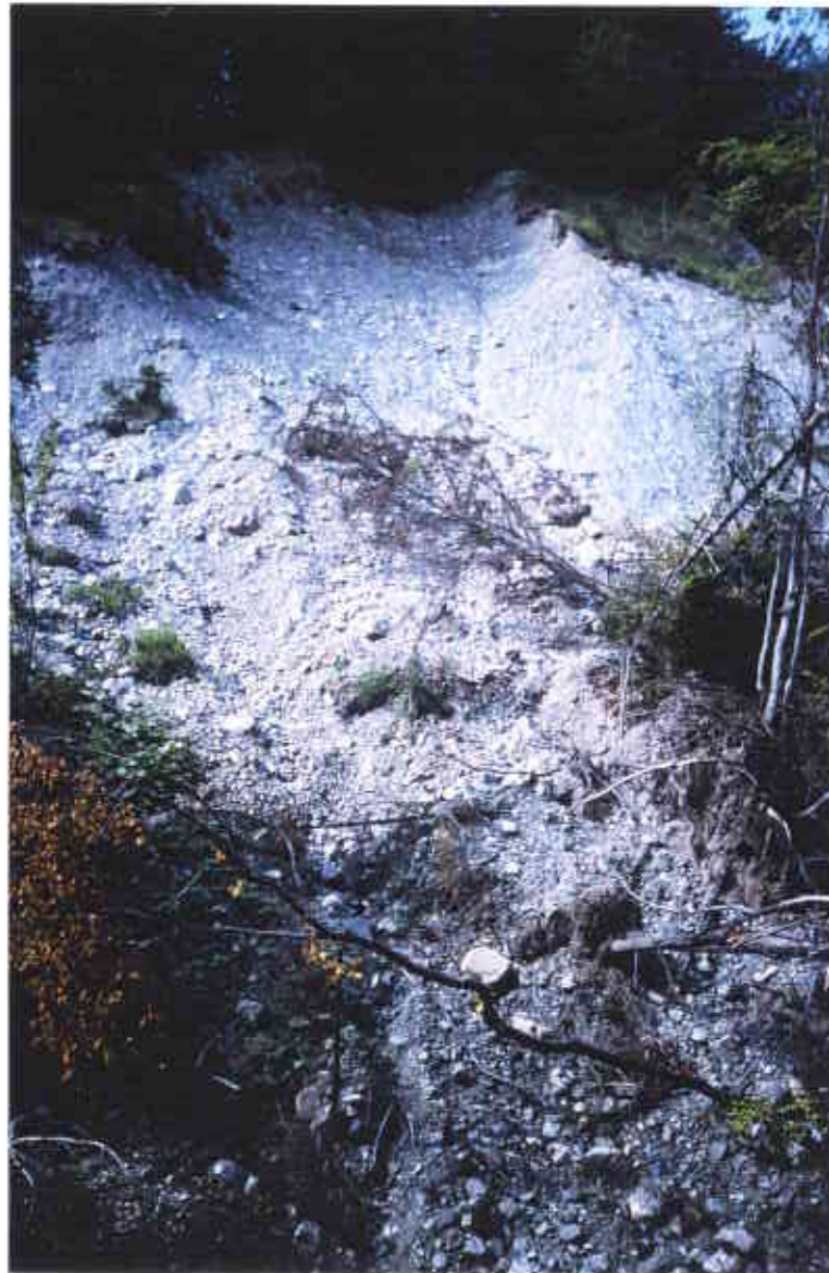
Photo 3 : Affouillement des berges de Fillian (secteur des Neigeux).
