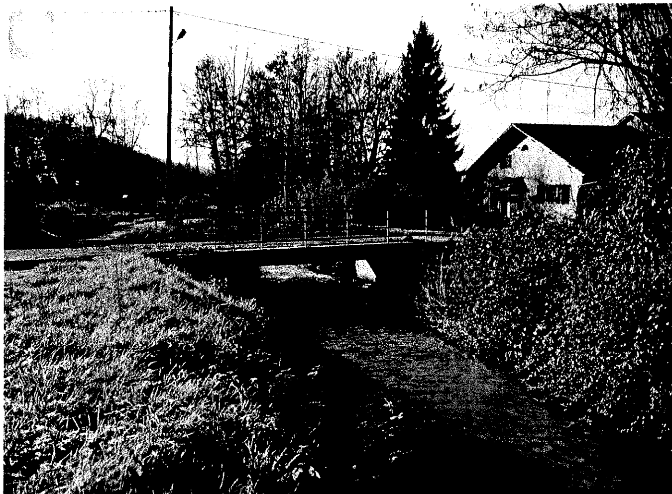
Torrent du Foron : pont de la Plantaz. La maison située en rive droite a été inondée à plusieurs reprises par les débordements du Foron. Cliché R. T. M. – XII 1994.
