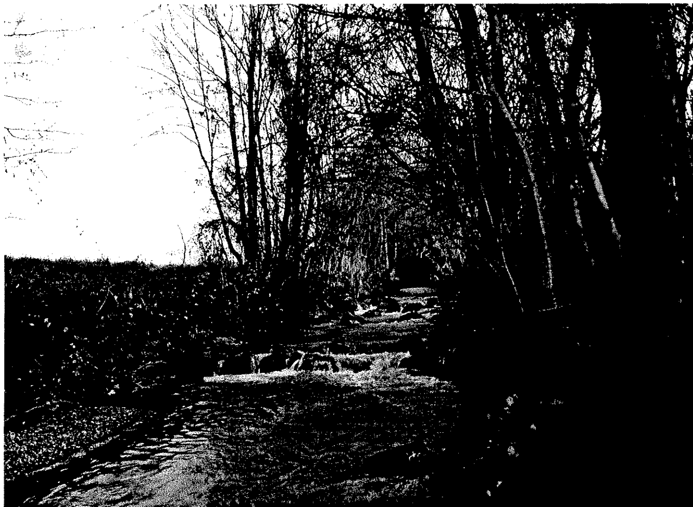
Torrent du Foron : série de seuils. Cliché R.T.M. – XII 1994.
