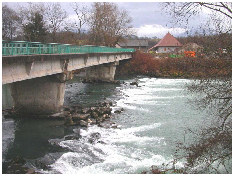
Reignier-OT2 : En aval du Pont Neuf (RD202) – Seuil en enrochements.
