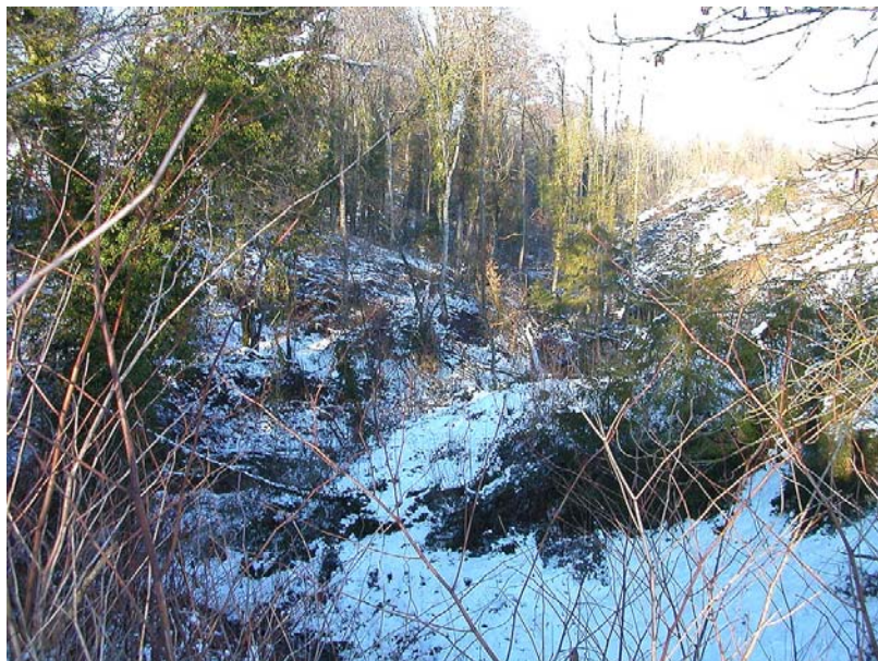
Reignier-EGT3 : Ruisseau le Moiron, à la RD302 – Thalweg marqué et boisé, localement déstabilisé.
