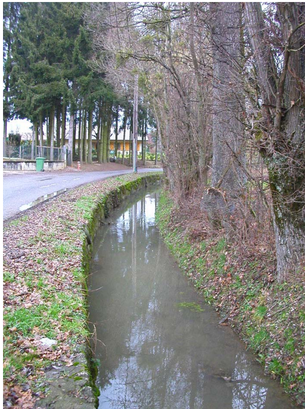
Reignier-OT3 : Hameau de Romboex – Canalisation d'un ruisseau le long d'une route.
