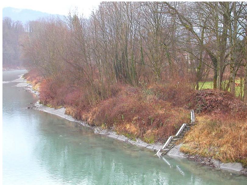
Reignier-OT1 : En amont du Pont Neuf (RD202) – Echelle limnimétrique sur la rive gauche.
