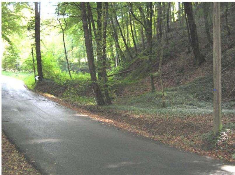
Chavanod-EG1 : Entre Chavanod et Belleville – Versant boisé en glissements et affaissements localisés de la chaussée.
