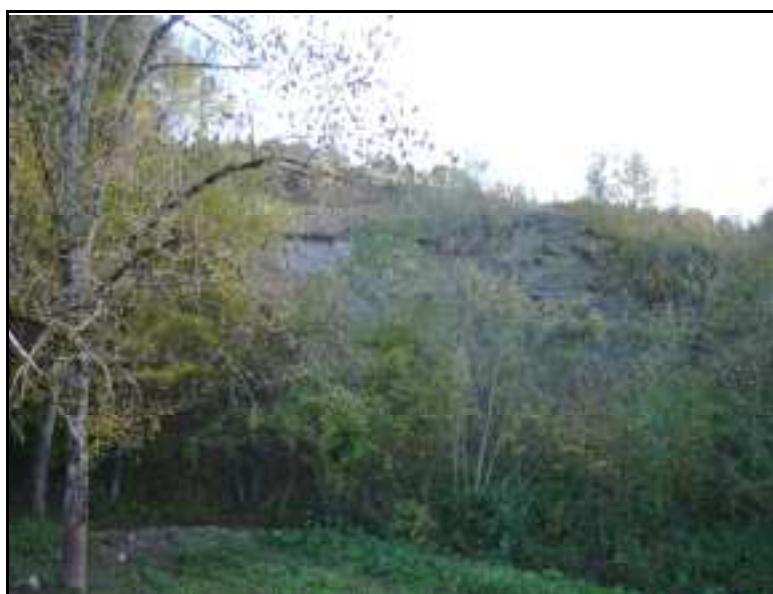
Mouvement de terrain dû à l'affouillement des berges du ruisseau du Pautex
