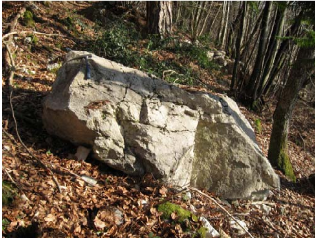
Photo 4 : Bloc de 2,4 m 3 tombé en 1996 au dessus du chemin de randonnée menant de la Combe au col des Contrebandiers (photo J. Lievois RTM Haute-Savoie 2009).
