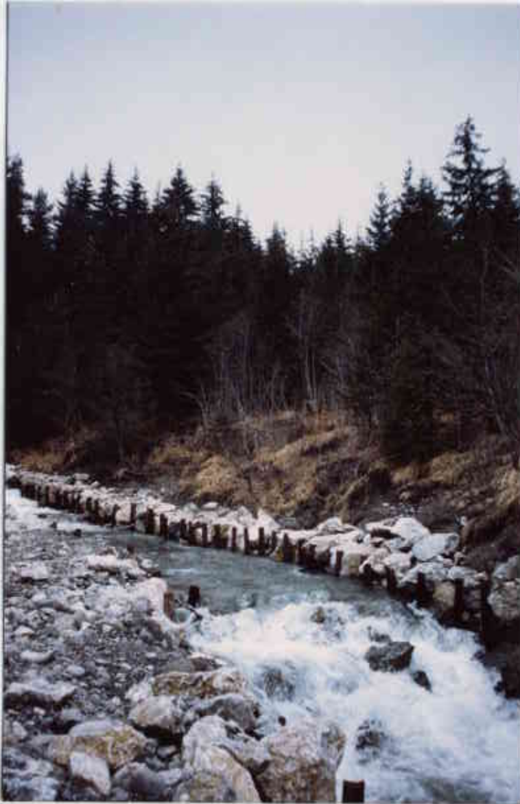
Consolidation de berge par pilotage et enrochement : Le Plan des Champs
