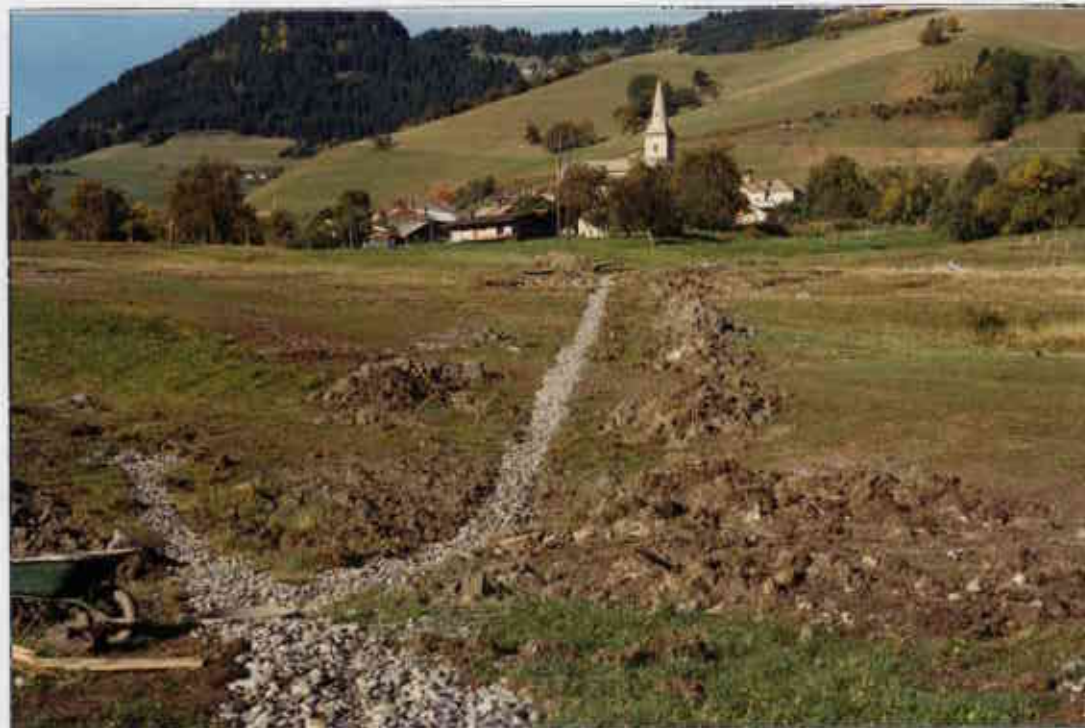
Le terrain après la pose des drains
