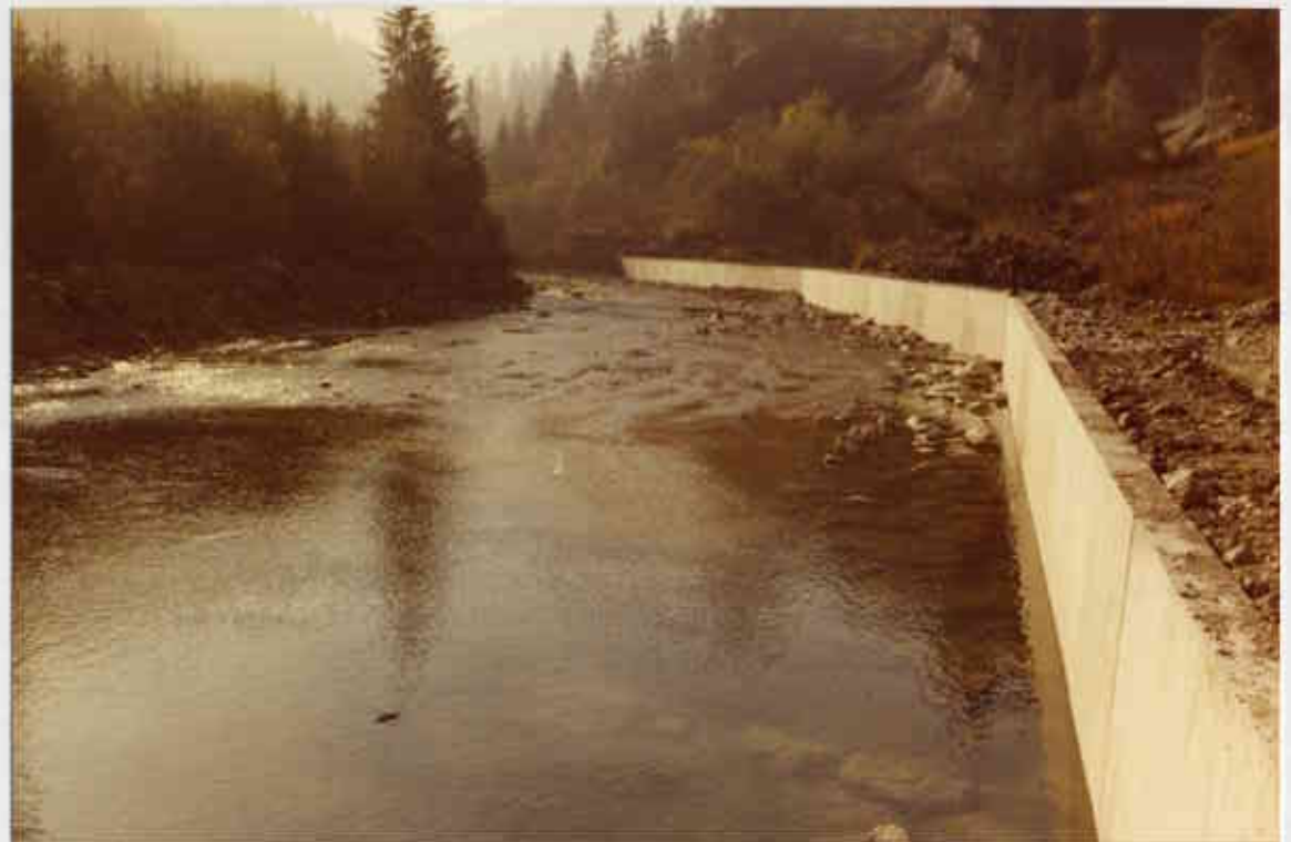
Consolidation de berge : digue sur le Brévon (1982)
