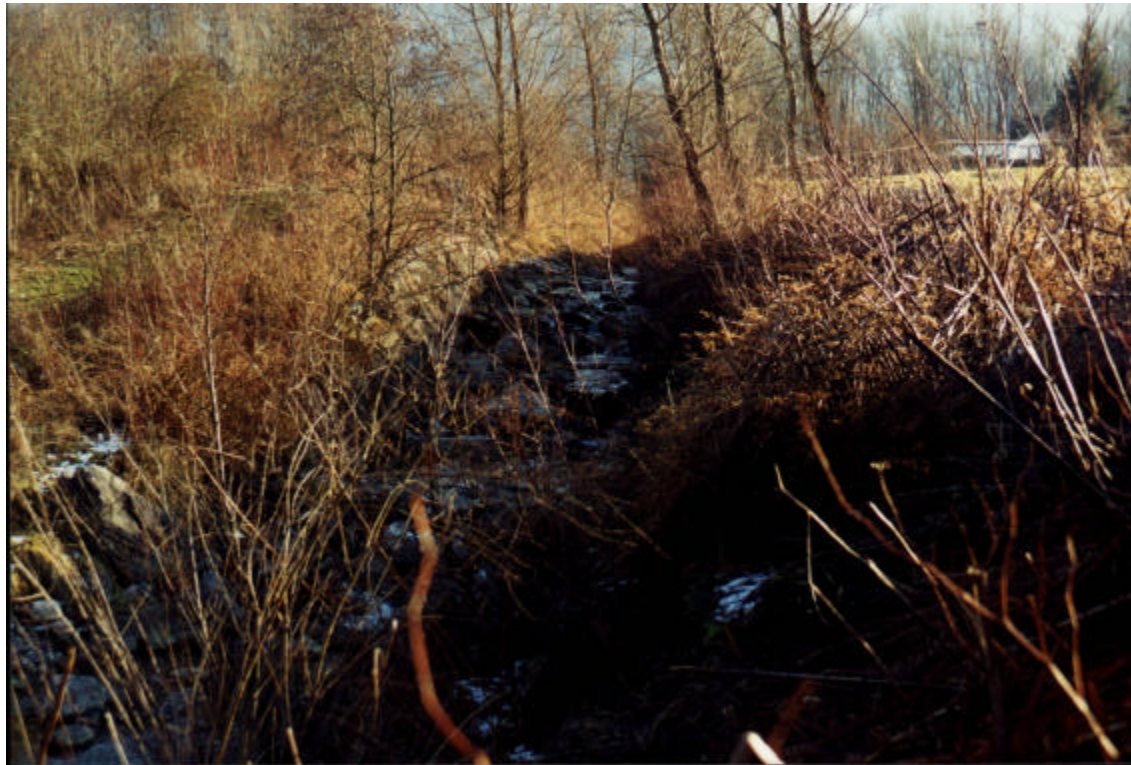
Photo 6 : Torrent de Marnaz au niveau des Valignons (Cliché RTM – 12 / 01 / 2000)
