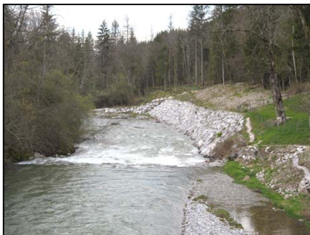
Fillière-03 : Confortement en enrochements sur la rive droite en aval du pont de Chez Milliard
