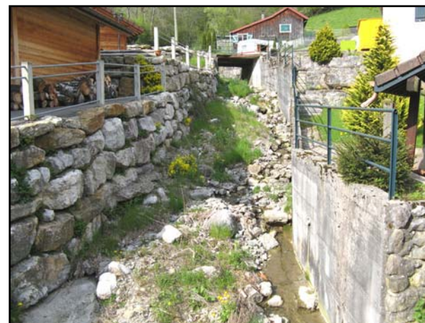
Figure 28 : Ouvrages de protection sur divers ruisseaux
