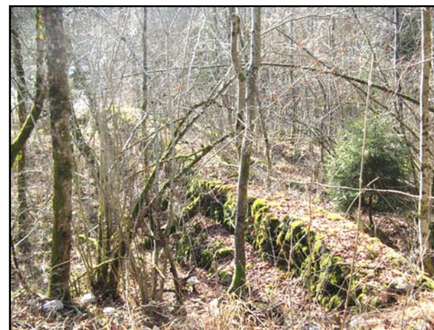
Fillière-04 : Anciens épis en gabions entre Chez Milliard et Gorez
