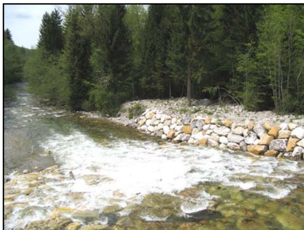
Fillière-01 : Seuil en aval du pont de la RD5, au niveau de la Vuaz
