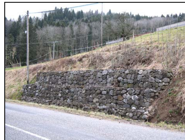
RD02-06 : Au Pont de la Zone, alt. 828m
