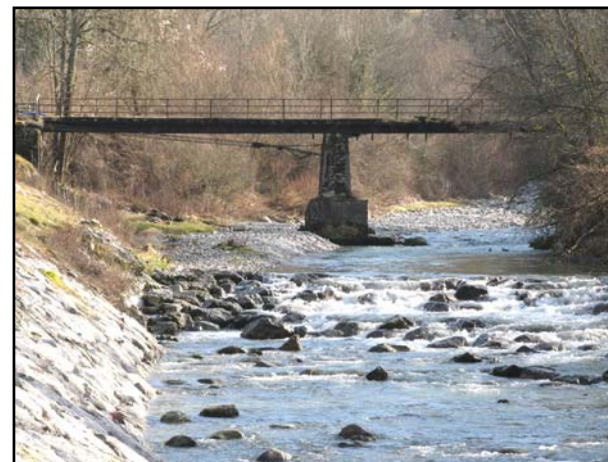
Fillière-02 : Seuil en aval du pont de Chez Milliard
