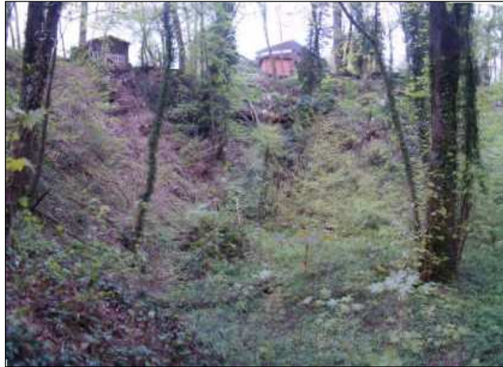
Photo 5 : glissement de terrain en amont de la RN5
