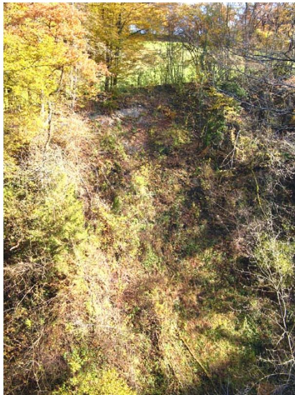
Etercy-EGT3 : Thalweg du Nant de Verne – Profondes gorges et pentes localement déstabilisées.
