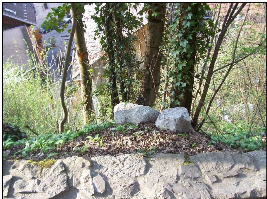
Figure 17: Le Thovey. Pierres isolées pouvant être remises en mouvement et atteindre les constructions en contrebas.
