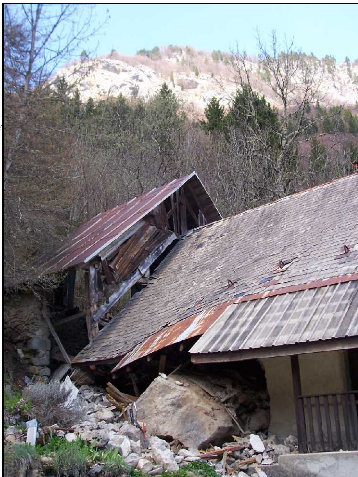
Figure 18: Un des chalets de Saint-Ruph atteint par un bloc en 2009. A l'arrière-plan, les falaises qui constituent la zone de départ des blocs.
