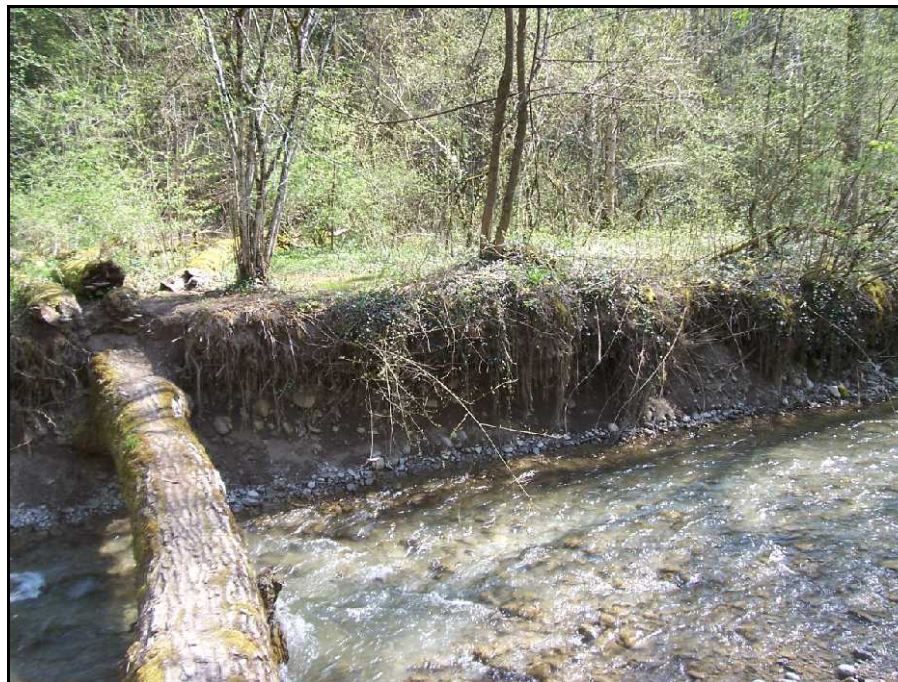
Figure 6: Affouillement de la berge rive droite sur le ruisseau de Montmin à l'aval du VILLARD.
