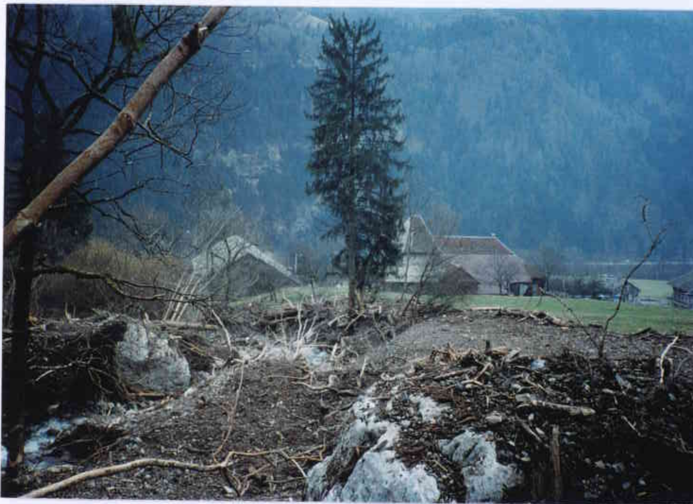
- Photo n° 20 : en février 1990, le Nant de la Ville a été soumis au charriage de matériaux par coulée de boue, eau et neige. A cet endroit, les eaux auraient pu sortir du lit du torrent (zone n° 151) -
