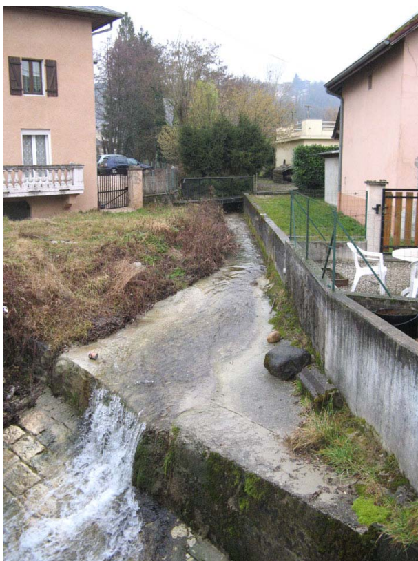
StFelix-ET1 : Nant Dorsan, en amont de la RN201 – Canalisation et cimentation du lit.
