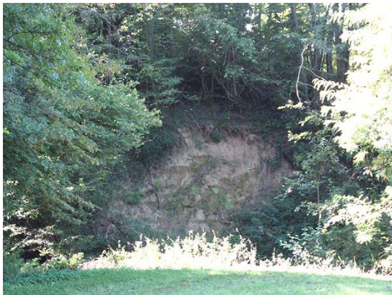
StFelix-EG1 : Ruisseau à Chamossat – Glissements au niveau des berges.
