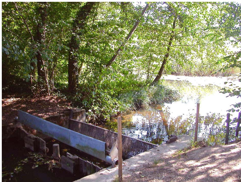
StFelix-OH1 : Entre les étangs de Beaumont et Crosagny – Grille de la vanne qui permet de réguler les écoulements entre les deux étangs.
