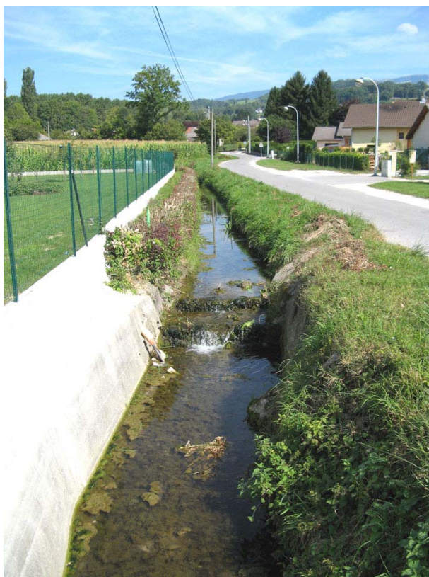
StFelix-OT1 : Ruisseau du Pontet, au Sud du Martinet – Canalisation du ruisseau dans un large fossé.
