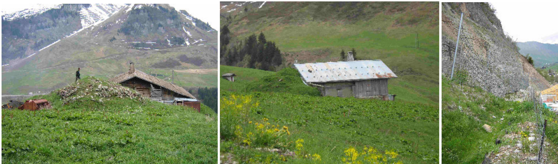
Exemples de protections anciennes et récentes : Étraves dans la vallée des Bouts (Les Bouts, La Sonnerie); petit merlon et filet pare-pierres à La Place.
