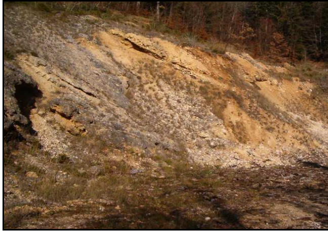
Le rocher affleure sur les flancs de la Grande Montagne, entraînant des chutes de pierres
