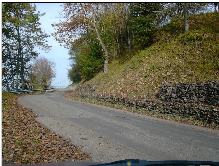
Protection en gabions au lieu dit « Cruet »
